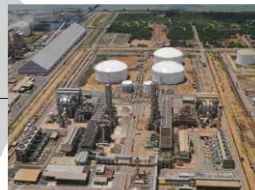
メタノール製造 (ベネズエラ)
