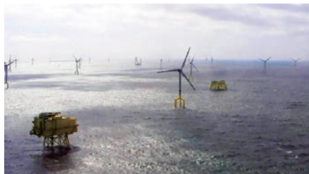
北海で建設中の海底送電線・洋上変電設備
